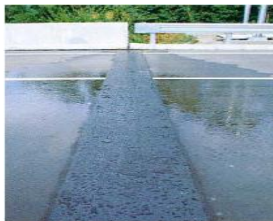
Photo 8-2 Flexible Asphalt pouring
